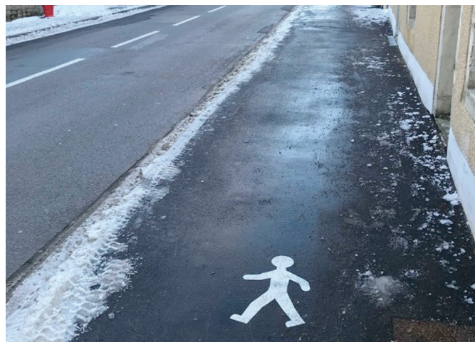
Élargissement du trottoir rue de la Batheuse
