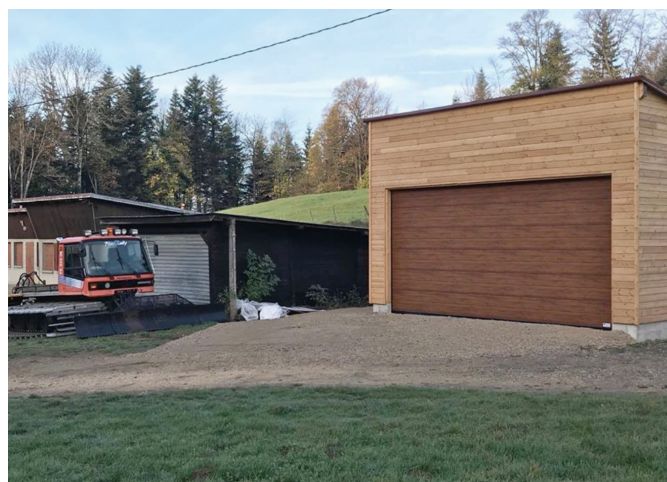
Construction d'un garage pour abriter le daleur, piste de ski de Goule.
