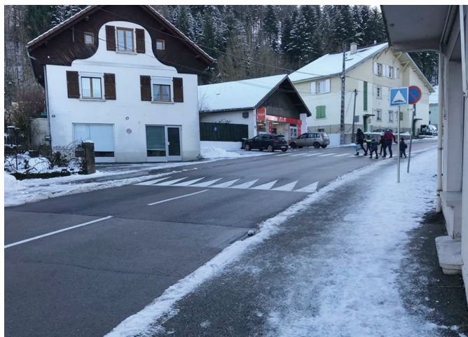
Aménagement d'un plateau avenue Leclerc
